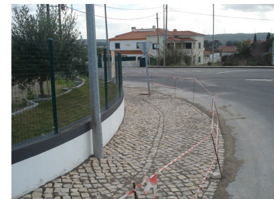
Calçada colocada na Estrada Nacional 114 / Estrada do Vau
