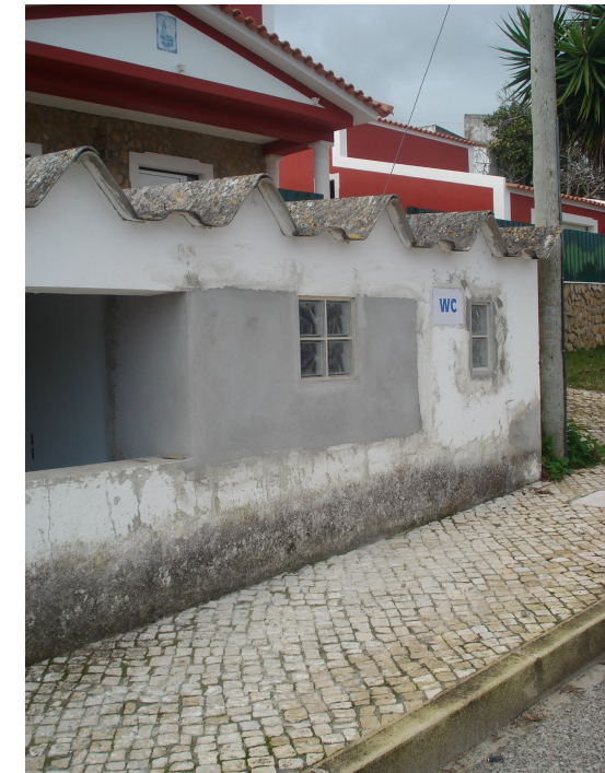
Construção de instalações sanitárias públicas, na rua da Mina
